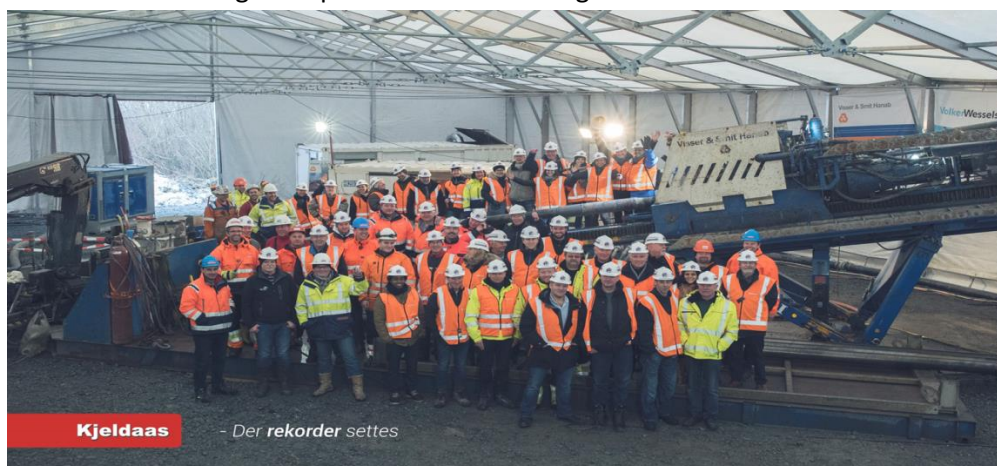
En flott samling prosjektmedarbeidere og riggen som ble benyttet til styrt boring under Glomma
